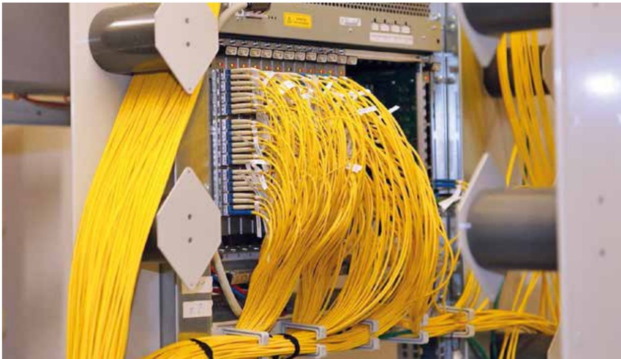
Der IP-MSAN MileGate ermöglicht eine hohe Flexibilität beim Netzausbau (Quelle: DZS)
